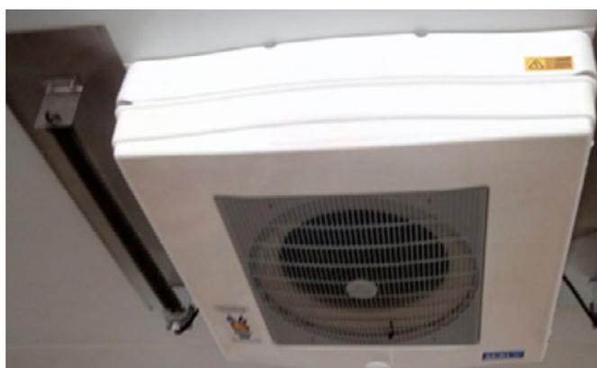
Les réglages pour le saucisson sec vont pour la température de 11 à 15 °C, pour l'hygrométrie de 72 à 85 % et de 0,05 à 0,1 m/s vitesse d'air au niveau des saucissons.
