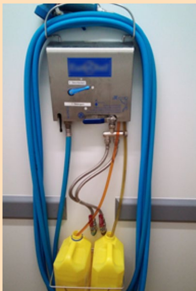
Exemple de centrale de nettoyage
